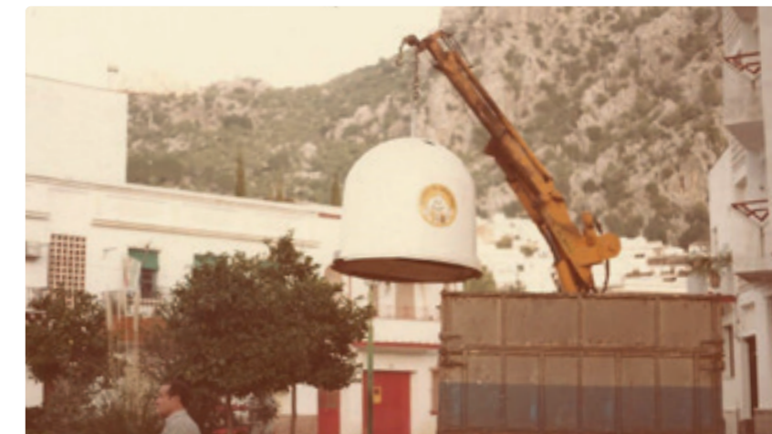
Instalación de un contenedor en la sierra de Cádiz a comienzos de los 80. Fuente: RAVSA.
